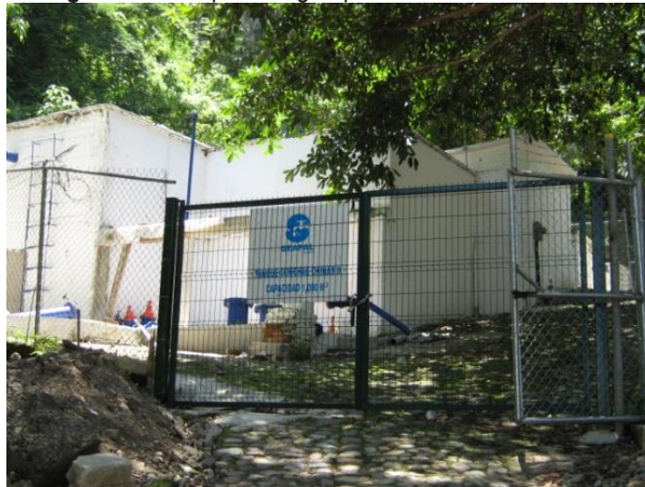
Imagen 13. Tanque de agua potable "Conchas Chinas II"
