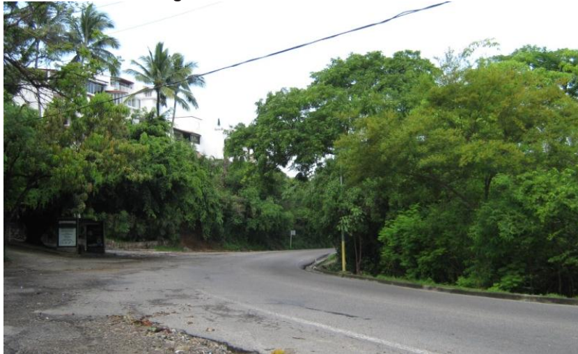
Imagen 15. Carretera federal no. 200
