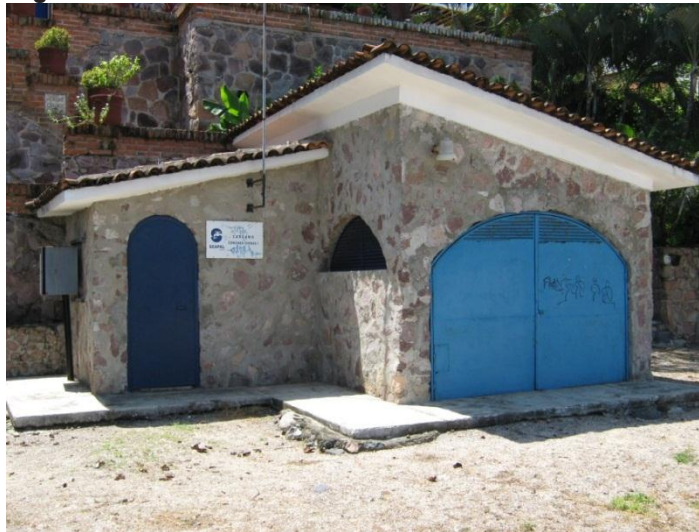
Imagen 14.- CÁRCAMO DE BOMBEO 'CONCHAS CHINAS II'
